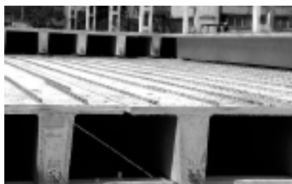
Fot. 5. Płyty TT, nazywane płytami \pi [1, 4]
