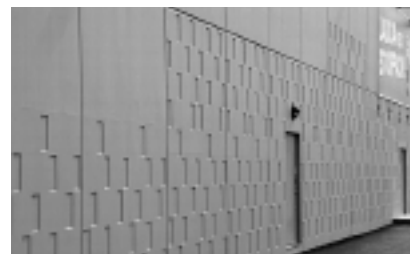
Fot. 8. Elementy ścienne w technologii betonu architektonicznego [1, 4]
