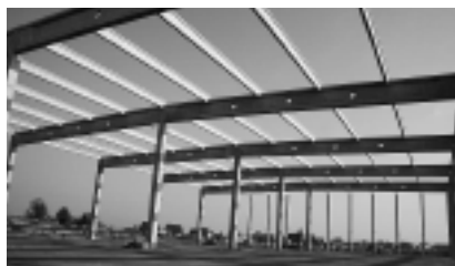
Fot. 2. Konstrukcja dachu [1, 4]
