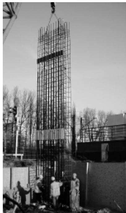
Fot. 1. Instalacja kosza zbrojonego ściany szczelinowej
