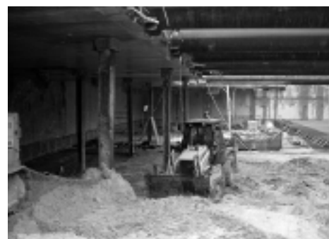
Fot. 2. Wykop docelowy budynku Equator 1
