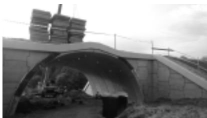
Fot. 2. Wiadukt WK-15 pod obciążeniem próbnym
