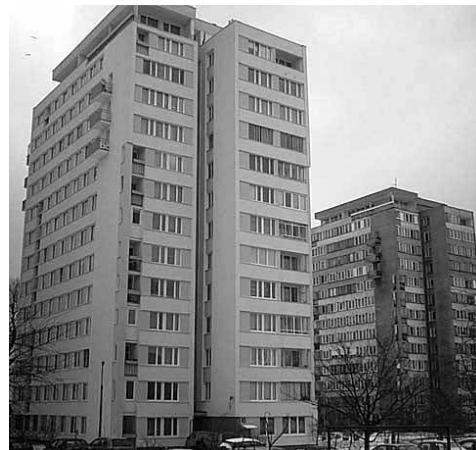
Budynek wielorodzinny przy ul. Bernardyńskiej 20 w Warszawie, w którym zmodernizowano instalację grzewczą
