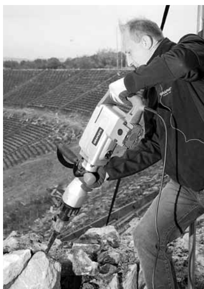
Kruszenie korony stadionu za pomocą młota udarowego Graphite 58G 857
