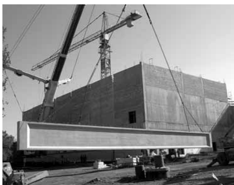
Montaż dwuteowego dźwigara dachowego, stałej wysokości (I-500/2400/32,0), długości 32 m w Centrum Handlowo-Rozrywkowym Real w Dąbrowie Górniczej
