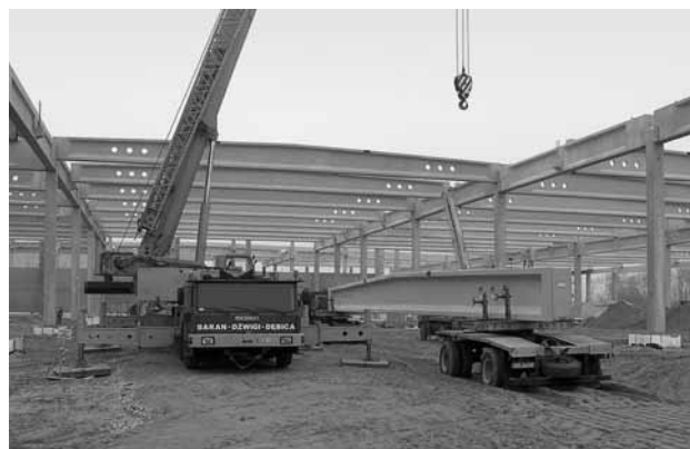
Zastosowanie dwuteowych dźwigarów dachowych, zmiennej wysokości (SI-500/1525/26), długości 26 m w nowo budowanym centrum dystrybucyjnym Lidl w Strykowie
