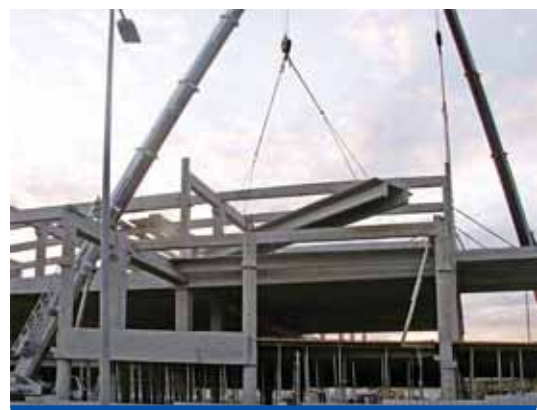
Montaż stropu na prefabrykatach TT typu Comfort w Centrum Handlowym Kaufland w Jastrzębiu-Zdroju
