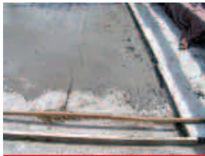
Wykonana warstwa szcpejna
