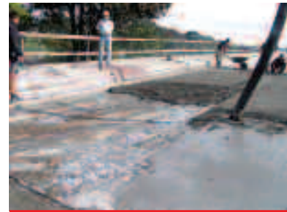
Rozkładanie mieszanki betonowej z włóknami RXF 54
