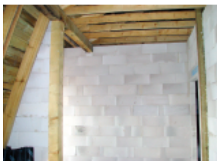
Ściana działowa z betonu komórkowego docięta do kąta nachylenia połąć dachowej
