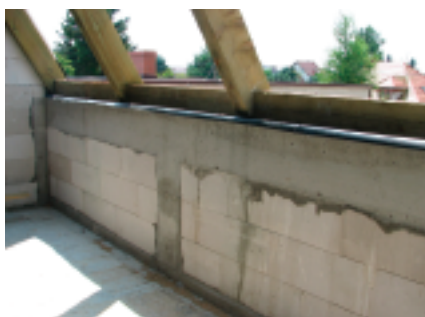
Wieniec pod murlatą oraz słupy żelbetowe w ścianie kolankowej
