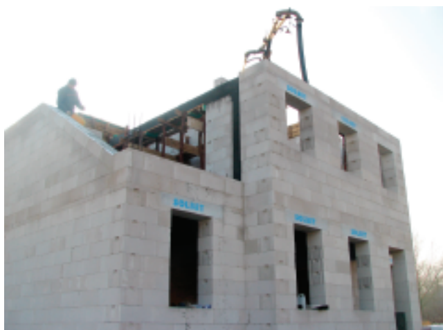
Budynek wzniesiony z elementów z betonu komórkowego w systemie SOLBET
