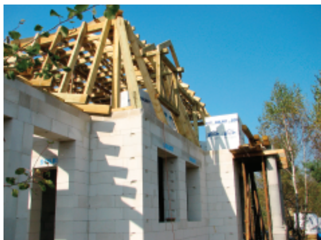
Kondygnacja poddasza wymaga zastosowania materiałów ściennych umożliwiających dopasowanie do kształtu konstrukcji
