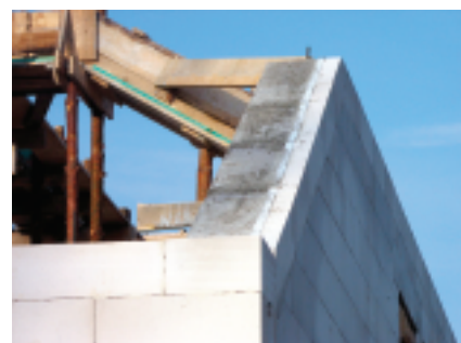
Wieniec w jednowarstwowej ścianie szczytowej ocieplony i obudowany płytami z ABK
