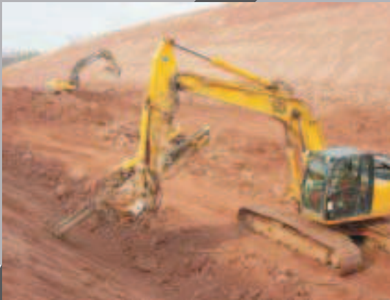
Zabezpieczenie skarp wykopu Droga ekspresowa S 7
