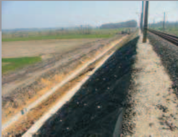
Wzmocnienie nasypu kolejowego Linia E 30
