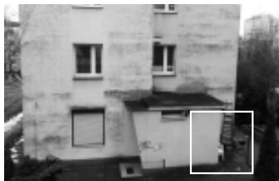
Fot. 2. Widok budynku od strony południowej wraz z zaznaczonym obszarem przemieszczeń
