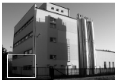
Fot. 3. Hala produkcyjna z zaznaczonym obszarem przemieszczeń
