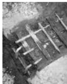
Fot. 3. Odkrywka pozwalająca zinventaryzować zbrojenie
