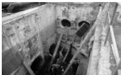
Fot. 1. Wzmocnienia ścian komory syfonowej przed rzeką przez betonowanie dodatkowego płaszcza żelbetowego
