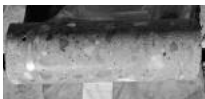
Fot. 3. Dobry stan betonu i zbrojenia (bez śladów korozji) w odwiercie rdzeniowym ściany komory
