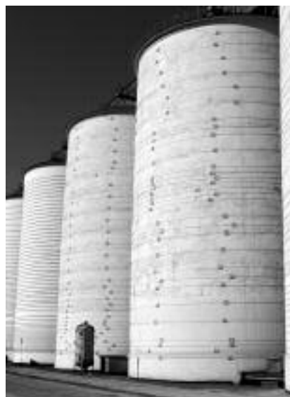
Wzmocnienie silosu obręczami stalowymi i kablami sprężającymi Silos strengthening by steel hoops and prestressing cables
