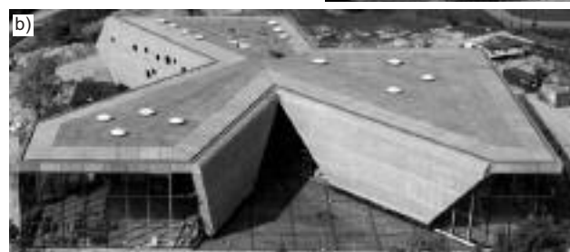
Przykłady realizacji obiektów z betonu architektonicznego w Polsce: a) Prosta Tower w Warszawie; b) Muzeum Lotnictwa w Krakowie [Źródło: Wikipedia; http://grcservice.pl/project/muzeum-lotnictwa-krakow/ ]
