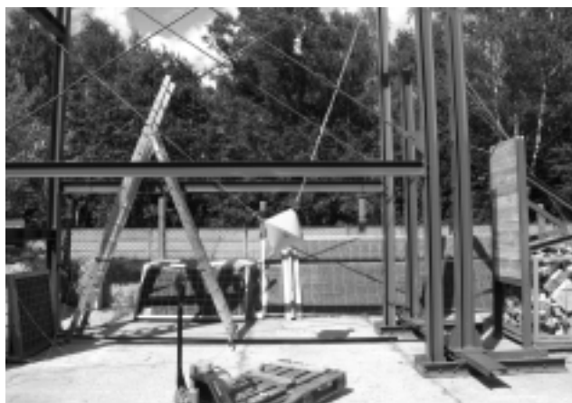
Fot. 2. Widok stanowiska z zawieszonym ciężarkiem
