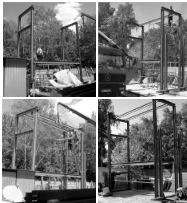
Fot. 1. Montaż stanowiska
