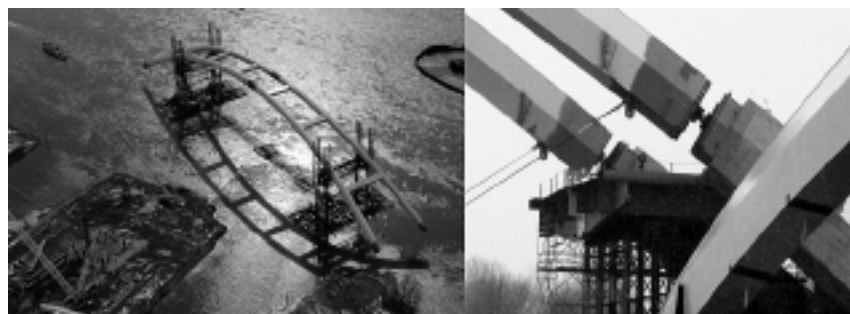
Fot. 3. Transport wodny łuków i osadzenie ich na węzłowiach
