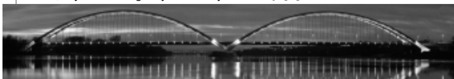
Fot. 2. Przęsła podwieszone mostu przez Wisłę w Toruniu
