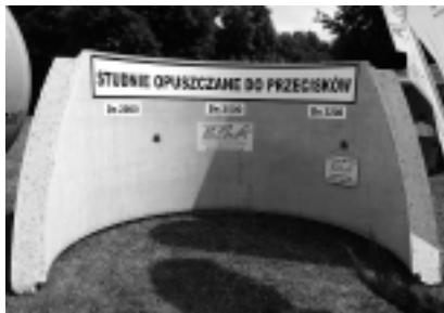
Fot. 3. Elementy prefabrykowane typowej komory startowej stosowanej w technologii bezwykopowej [Fot. A. Wysokowski] Photo. 3. The prefabricated elements typical starting shaft used in the No-Dig technology
