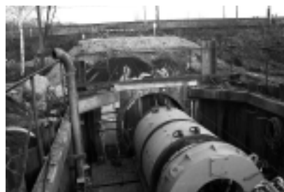
Fot. 4. Widok komory startowej w trakcie wykonywania przepustu metodą mikrotunelową pod linią kolejową w Ostrowie Wielkopolskim [Fot. Hobas] Photo 4. View of the starting shaft of culvert during construction in microtunneling technology under the railway line in Ostrow Wlkp.
