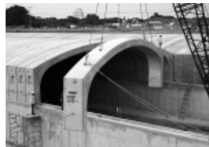
Fot. 4. Montaż ustroju nośnego
