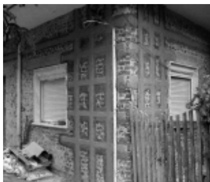
Fot. 1. Przykład wzmocnienia naroża budynku laminatami GFRP [Fot. Autorzy] Photo 1. Example of strengthening a corner of a building with GFRP laminates
