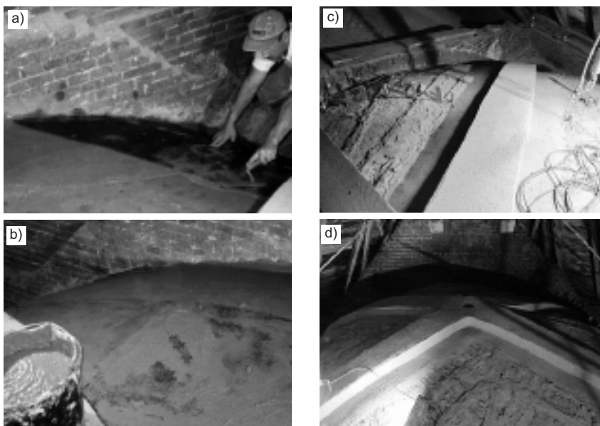
Fot. 2. Naprawa żeber i łęku sklepień krzyżowych systemem FRCM: a) wtopianie siatki z włókien węglowych na powierzchni łęku; b) częściowo wtopiona siatka; c) i d) wzmocnione żebra [Fot. Autorzy]
