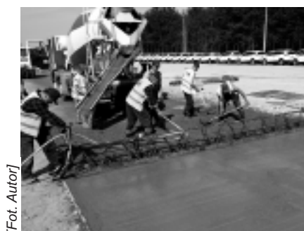
Fot. 1. Formowanie nawierzchni kompozytowej na podbudowie z kruszonego betonu Photo 1. The formation of the composite surface on the crushed concrete base
