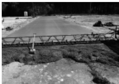
Fot. 2. Pneumatyczna listwa wibracyjna z przesuwem wciągarkowym [Fot. Autor] Photo 2. Pneumatic vibrating screed with winch moving
