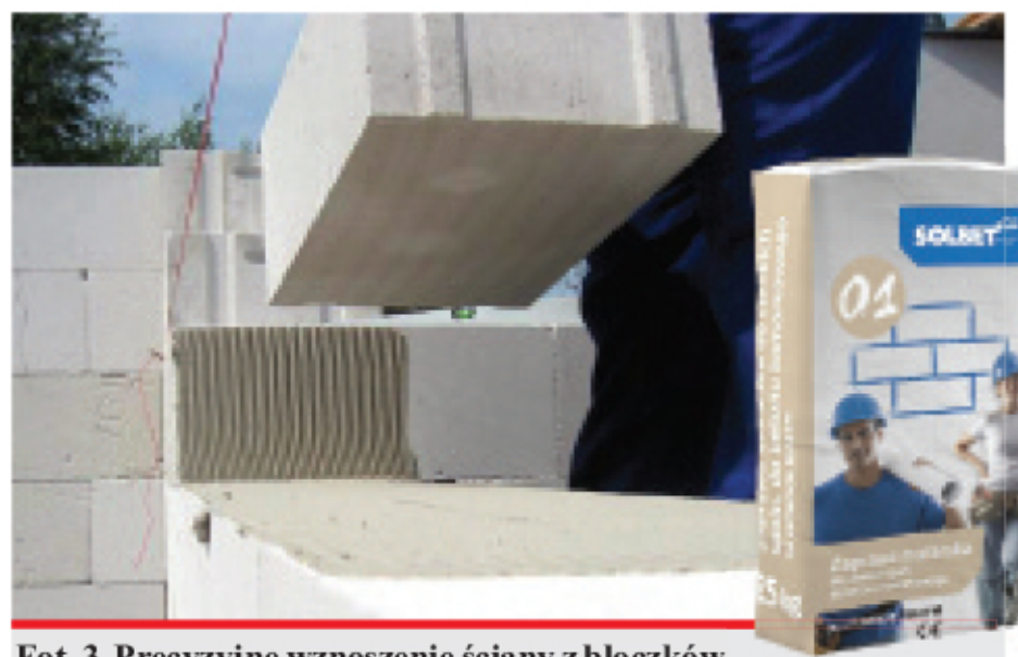
Fot. 3. Precyzyjne wznoszenie ściany z bloczków SOLBET na zaprawie murarskiej do cienkich spoin SOLBET 0.1
