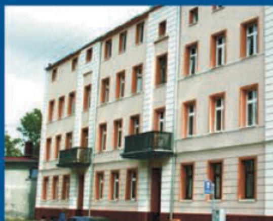
Budynek po osuszeniu i renowacji – Jelenia Góra
