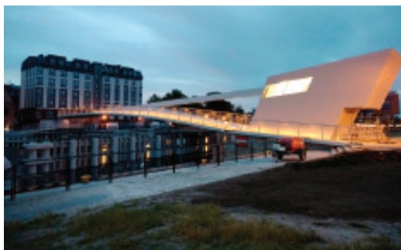
Kładka nad Motławą została wyposażona w napęd hydrauliczny firmy Bosch Rexroth
