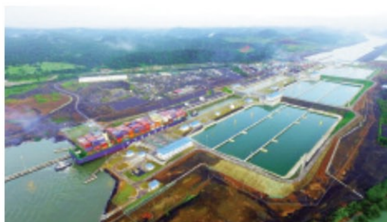
Kanał Panamski po modernizacji napędów mechanicznych
