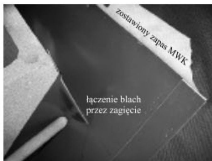
Fot. 2. Zagięta dolna krawędź kołnierza pasa bocznego
