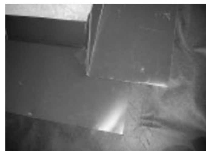
Fot. 1. Połączenie membrany z kominem za pomocą metalowego pasma pośredniego
