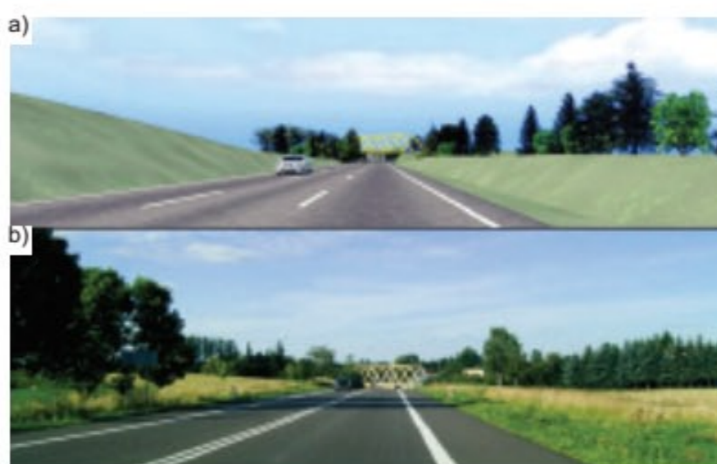
Rys. 3. Przykład wirtualnej rzeczywistości (VR – Virtual Reality) w przypadku obniżenia niwelety drogi: a) obraz wygenerowany z modelu 3D; b) fotografia stanu istniejącego [3]
