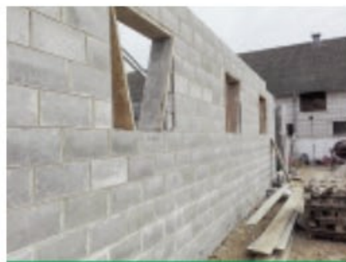
Ściana budynku gospodarczego w Systemie Śniadowo
