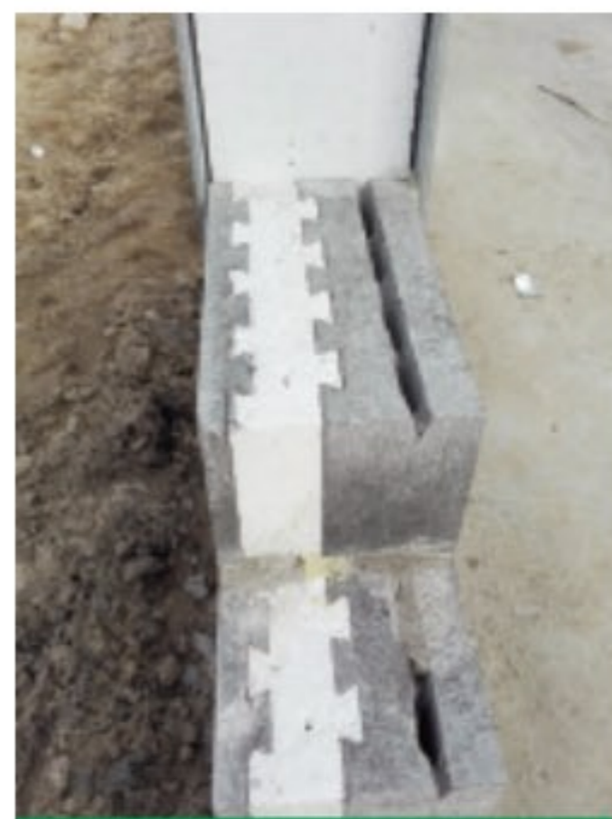
Murowanie ściany z Termobloczków TR-400/240/200
