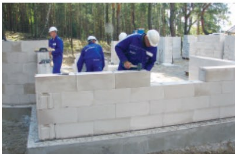
Wznoszenie ścian w systemie SOLBET jest łatwe i szybkie
