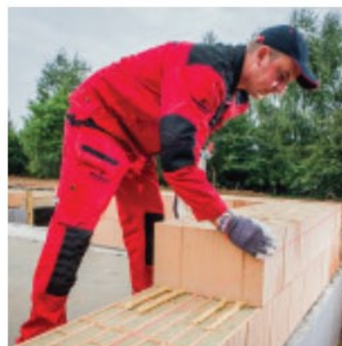
Fot. 3. Wznoszenie muru z pustaków Porotherm T Dryfix z zastosowaniem zaprawy do murowania na sucho Porotherm Dryfix
