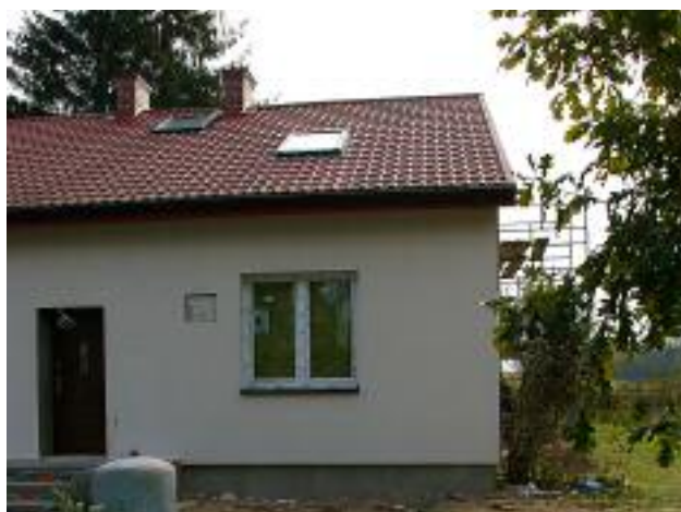
Fot. 7. Dom jednorodzinny poddany głębokiej termomodernizacji
