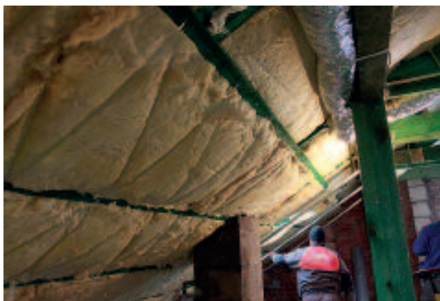
Fot. 6. Izolacja dachu wełną mineralną ISOVER Multimax 30
