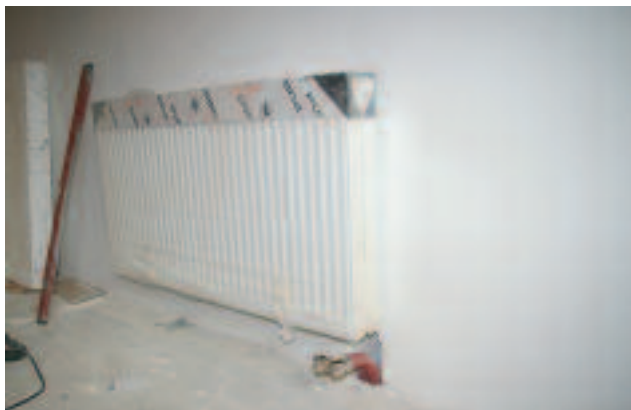
Fot. 5. Stalowe grzejniki płytowe z bocznym podłączeniem do instalacji
