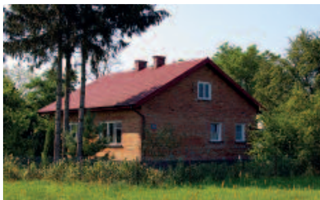
Fot. 1. Dom jednorodzinny przed termomodernizacją
