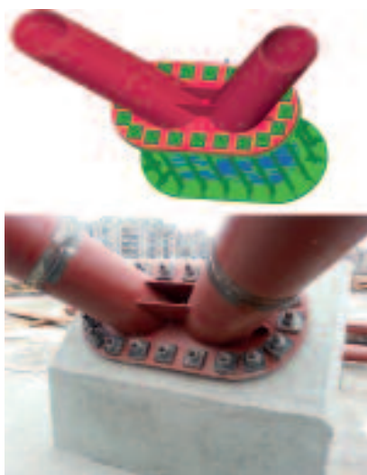
Rys. 1. Zakotwienie konstrukcji – widok w modelu Tekla Structures oraz z placu budowy
