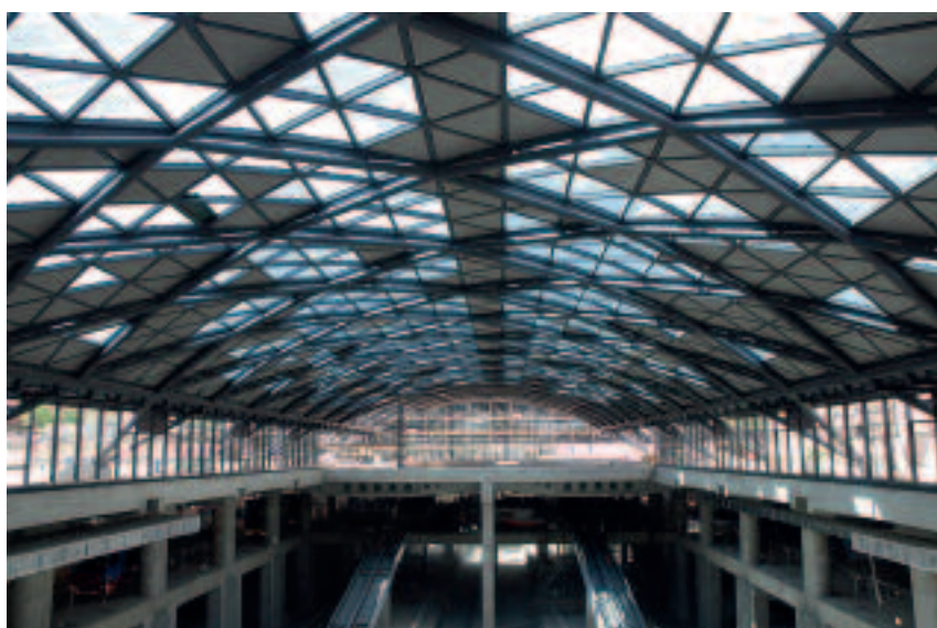
Fot. 1. Część świetlika B multimodalnego Dworca Łódź Fabryczna
