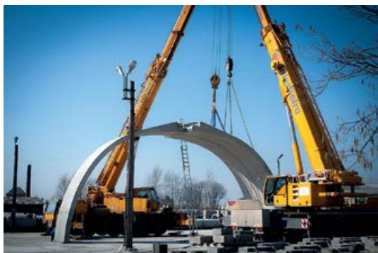
Próbny montaż elementów łukowych typu Freyssinet
