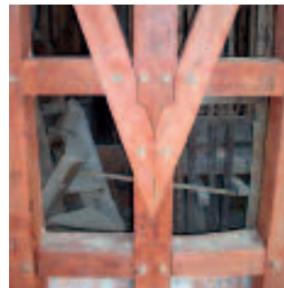
Fot. 8. Widok odtworzonej konstrukcji ściany z zachowaniem oryginalnych złączy ciesielskich
