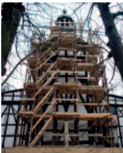
Fot. 6. Zewnętrzne, drewniane rusztowanie wieży
