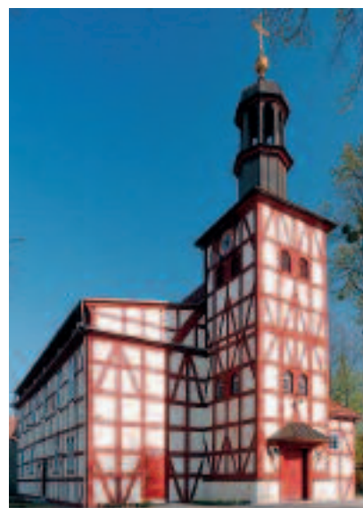
Fot. 9. Widok wieży kościoła pw. św. Anny na Praczach Odrzańskich po remoncie
