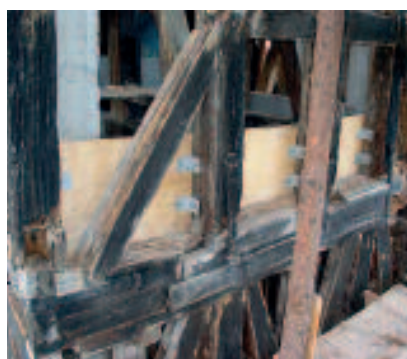
Fot. 7. Drewniany szkielet zachodniej ściany wieży na połączeniu wyższego czołnu wieży z niższym. Z tyłu widoczna żelbetowa rama wzmocniająca
