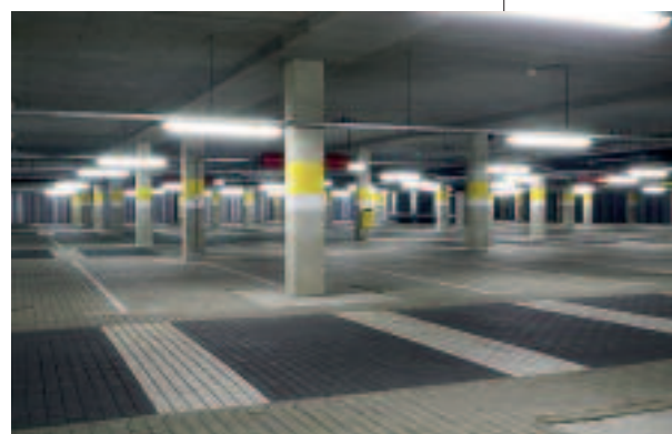
Fot. 2. Podziemny garaż parkingowy z nawierzchnią przepuszczalną z kostki brukowej
