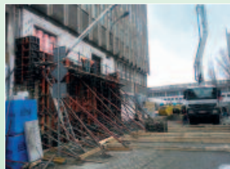
Osłony z betonu ciężkiego magnetytowego przeznaczone do rozbudowy Centrum Medycznego HCP w Poznaniu
