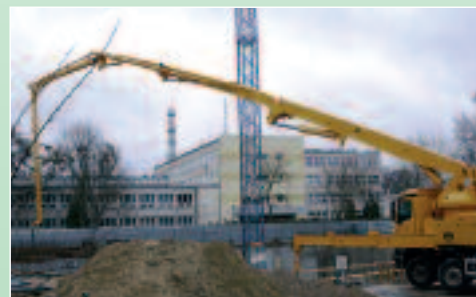
Wspólnie z firmą Hydrobudowa1 Betoniarnia Laboratorium Sp. z o.o. wyprodukowaliśmy i dostarczyliśmy beton magnetytowy na potrzeby Budowy Ośrodka Radioterapii na terenie Centralnego Szpitala Klinicznego (CSK) MSW w Warszawie
