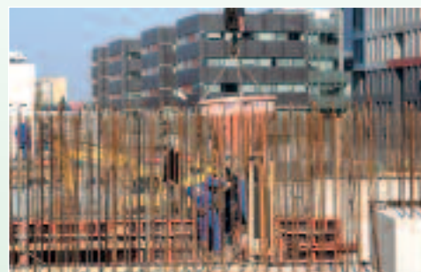
Dostawy betonu magnetytowego na budowę Laboratorium Badań Nieniszczących we Wrocławskim Parku Technologicznym
