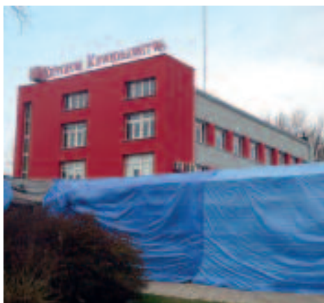
Zabezpieczenie elewacji podczas prac ociepleniowych w okresie jesienno-zimowym
