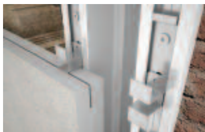
Przykład montażu fasady wentylowanej w systemie niewidocznym
