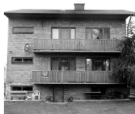
Fot. 1. Budynek jednorodzinny (wybudowany w 1986 r.) poddany badaniu szczelności
