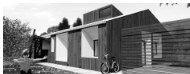
Fot. 2. Widok domu – wnęki okienne pełniące rolę osłon przeciwsłonecznych
