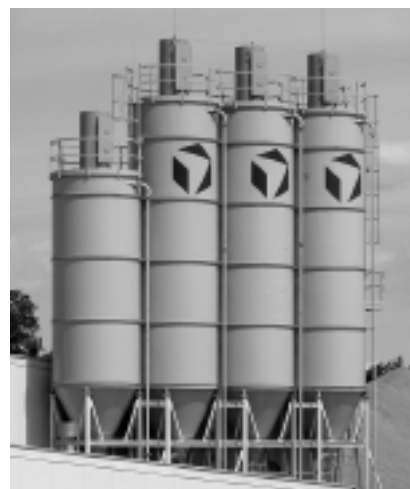
Silosy stalowe oparte na głowicach słupów [Fot. E. Hotała]
