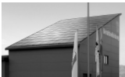
Fot. 3. Integracja ogniw fotowoltaicznych przez aplikację – dach budynku usługowego w Ibbenbüren, Niemcy
