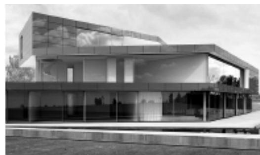
Fot. 2. Przykład zastosowania bezramowych paneli fotowoltaicznych zintegrowanych z fasadą – projekt autora
