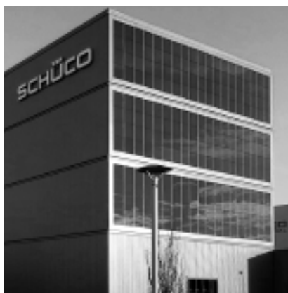
Fot. 4. Integracja ogniw fotowoltaicznych przez konstrukcyjną addycję – hala fabryczna w Bielefeldzie, Niemcy
