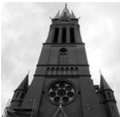
Fot. 2. Elewacja frontowa wieży. Widok na zwieńczony kwiatonem portal główny, rozetę główną, galerijkę arkadową i gzymsy Photo 2. Front elevation of the tower. View of a front portal topped with a fleuron, an oculus, a small arcade gallery and cornices
