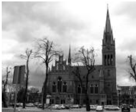
Fot. 1. Widok ogólny kościoła Photo 1. General appearance of the church
