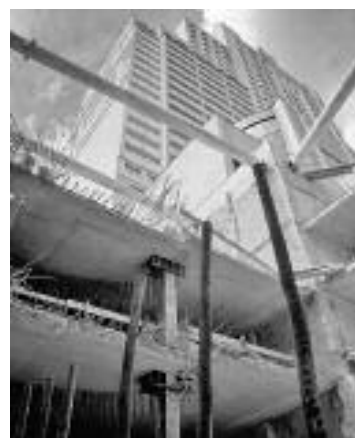
Fot. 3. Metoda stropowa – stropy kolejnych kondygnacji widziane z poziomu płyty dennej [1]
