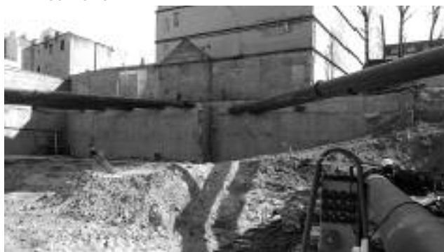
Fot. 2. Ściany szczelinowe rozparte stalowymi rozporami rurowymi [Fot. Autorzy]
