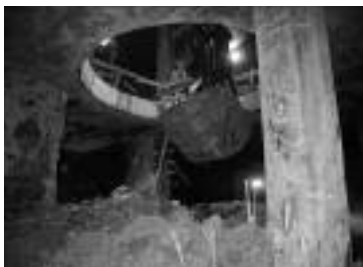
Fot. 4. Wydobywanie urobku przez otwór technologiczny [3]
