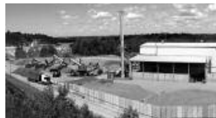
Fot. 1. Pierwszy zakład wytwarzania kruszywa z popiołów w technologii LSA w Sowłanach uruchomiony w 2015 r., zlokalizowany przy haldzie popiołów
