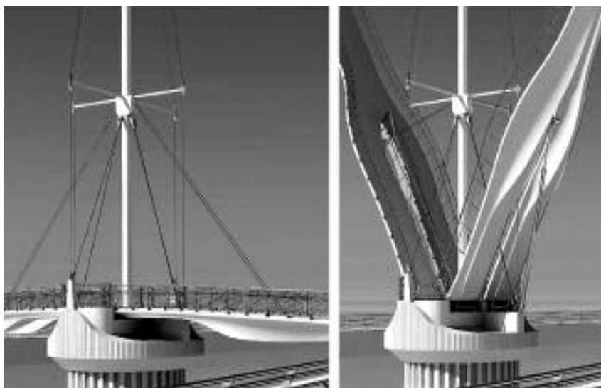
Kompozytowa kładka Pont y Ddraig na rzece Clwyd w Port Rhyl – Północna Walia – za [4]
