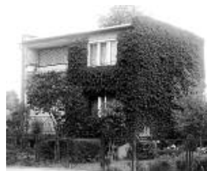
Zielona fasada bezpośrednia, budynek mieszkalny, Nowa Sól [Fot. A. Rumijowska] Traditional Green Façade, residential building, Nowa Sól [Photo A. Rumijowska]
