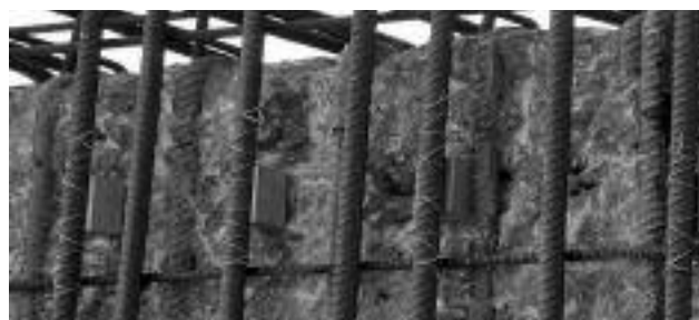
Podpora zadaszania punktu poboru opłat, Brzeziny-Kowal
