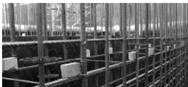
Zbrojenie pompowni wody, Kozienice
