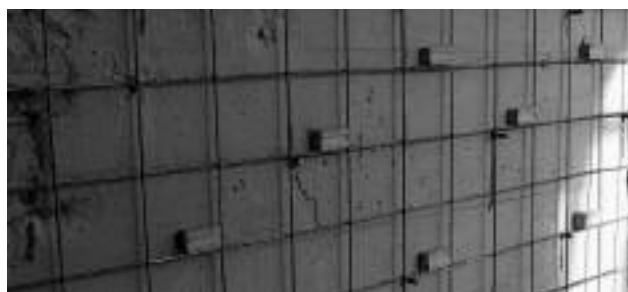
Podpora wiaduktu kolejowego, Lublin
