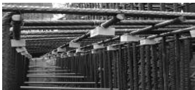
Przyczółek mostu, Pruszków
