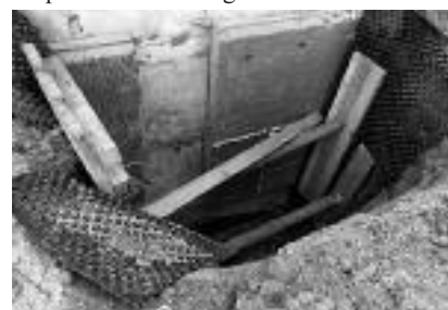
Fot. 2. Przykład wykonania izolacji ze szlamu elastycznego na zewnątrz budynku
